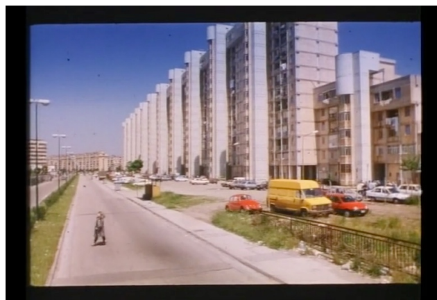
Fig. 8: Costituzione di Napoli a Secondigliano/Scampia
