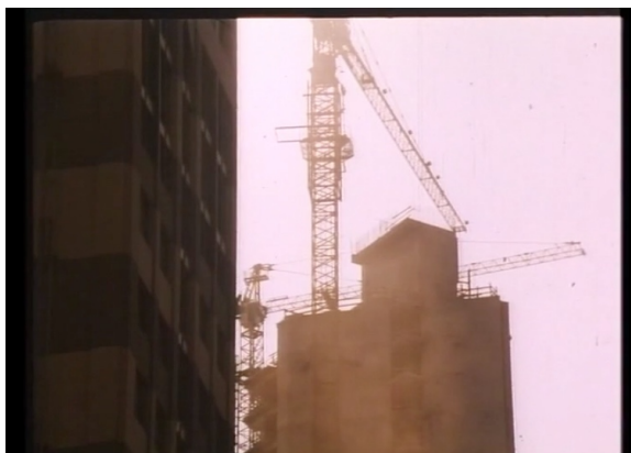
Fig. 14: Dettaglio di cantiere nel Centro Direzionale
