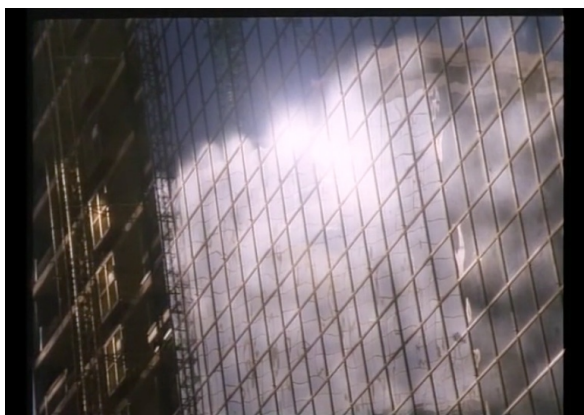
Fig. 12: Dettaglio di facciata del Centro
